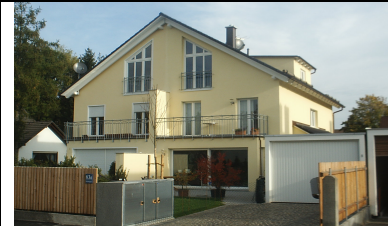
Bau DHH München / Heilwigstr. 2004
